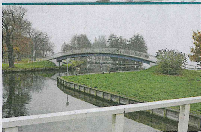
In diesem Bereich werden die Arbeiten weiter erfolgen.
